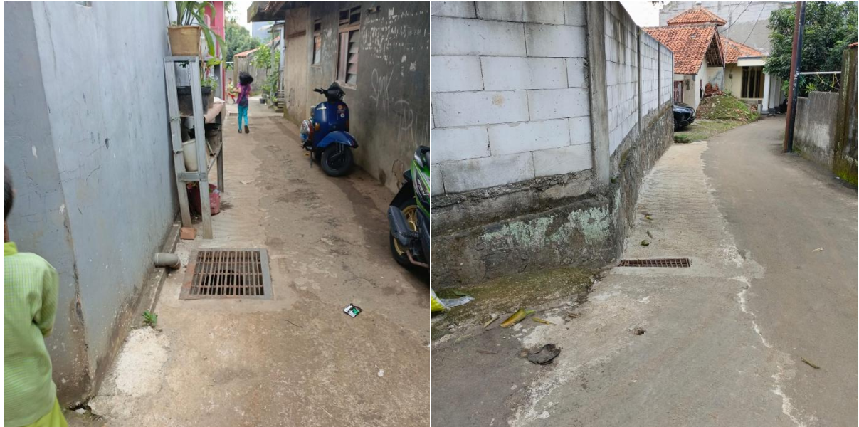
Gambar 7 Pembangunan Drainase di Bogor Barat oleh PT. Selaras Muslim Abadi
