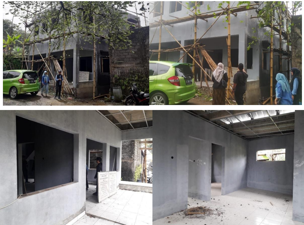
Gambar 3. 10 Monitoring Pembangunan Puskesmas Pembantu Kelurahan Pamoyanan
