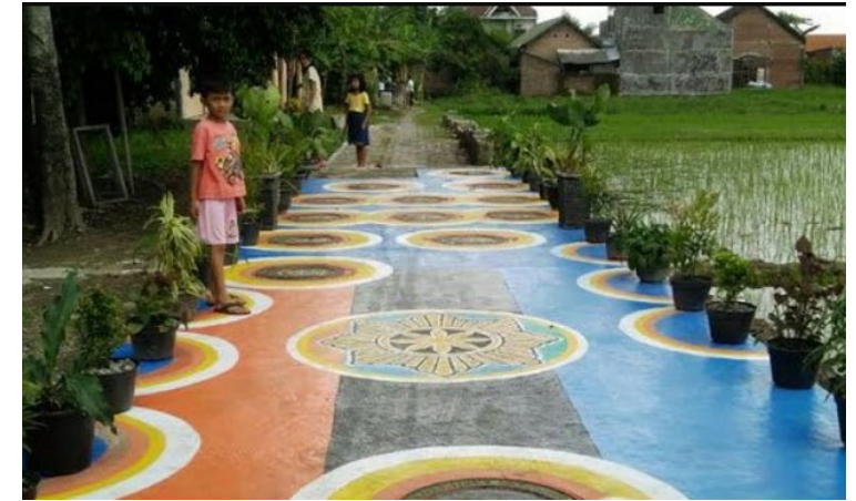
IPAL Komunal pada Jalan Lingkungan di Mojokerto
